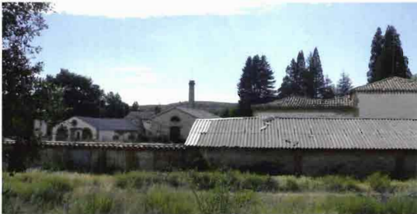
Fig. 16.- Antigua fábrica de resinas 'La Concepción'. (Matamala de Almazán, Soria).
